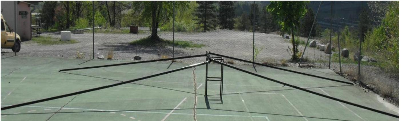
2 – Relier les 2 pieds du fond entre eux par la barre au sol qui se manchonne dans les socles, puis les 2 socles « côté manchons fixes » doivent être bloqués soit par 2 personnes, soit en plantant des piquets dans le sol, soit en attachant les socles à un point fixe aligné (poteau, arbre, véhicule...).
